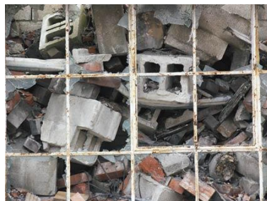
Residus de demolició d'edificis
